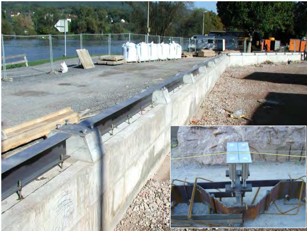
Stützenarmierung mobiler Elemente am Main in Miltenberg (Lkr. Aschaffenburg)
