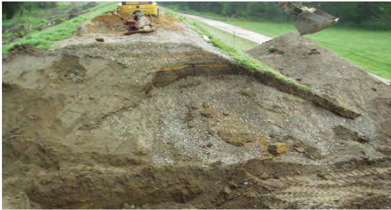
Flussdeich an der Donau bei Vohburg (Lkr. Pfaffenhofen a.d.Ilm ) Baujahr um 1890, verstärkt und erhöht 1956
